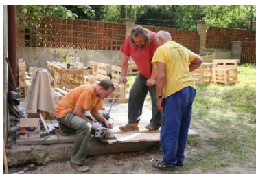
např.: 2015 / budování mezigenerační zahrady
